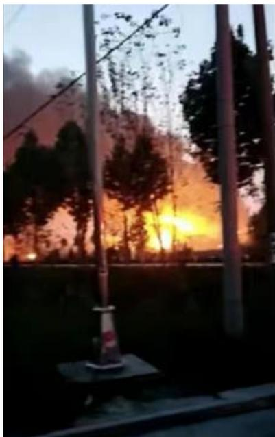
高青県の応急管理部の責任者の話によりますと、爆発発生前に、中央制御室のモニタリング設備を通じて、担当者が事前に異常を発見し、就業中の従業員らに速やかに避難を指示したために被害が抑えられたということです。事故の原因についてはまだ調査中ですが、バルブの故障により漏れ出したブタジエンに引火したことが原因とみられています。
